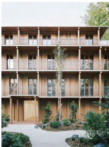
Træ konstruktion med indeliggende altaner.
